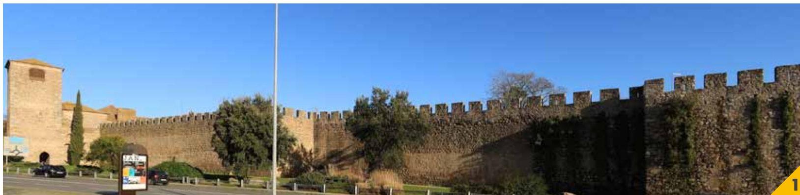
1. Conjunto amuralhado de Évora, alvo de diversas Intervenções ao longo da história.
