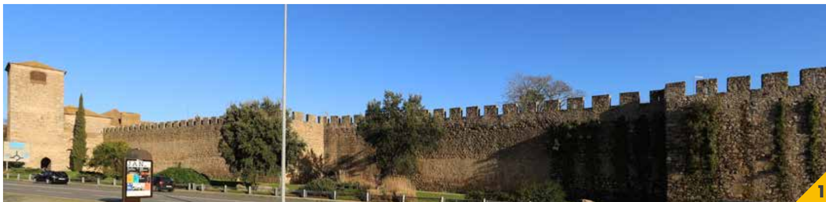
1. Complexe fortifié à Évora, la cible de plusieurs interventions à travers l'histoire.
